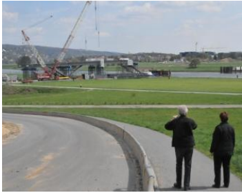
Die Baustelle der Dresdner Waldschlösschenbrücke wird zunehmend ein beliebtestes Fotomotiv.
