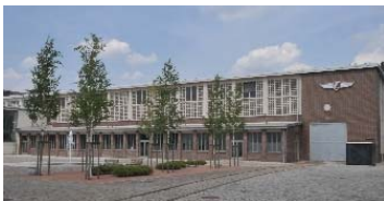
Als „Zeitenströmung“ mit Autosalon und Eventlocation wurde die Industriebrache eines ehemaligen DDR-Kombinates denkmalgerecht restauriert. Foto: Ruhnau
