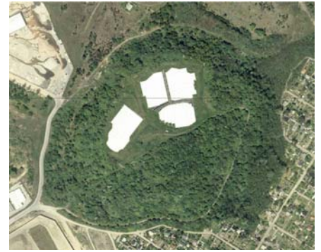
Abb. 4.8: Sondermülldeponie Hammerweg mit Becken vor der Sanierung
