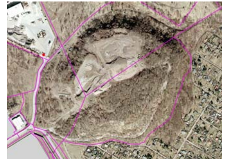
Abb. 4.9: Deponie in der Bauphase mit entleerten und rückverfüllten Becken
