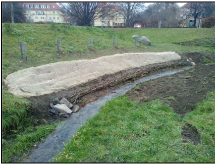
Abb. 3: Nach der Maßnahme: Ingenieurbiologische Ufersicherung und Ergänzung des Gehölzgürtels durch Erlen-Anpflanzung und Weiden-Lebendfaschinen, 10.12.2020
