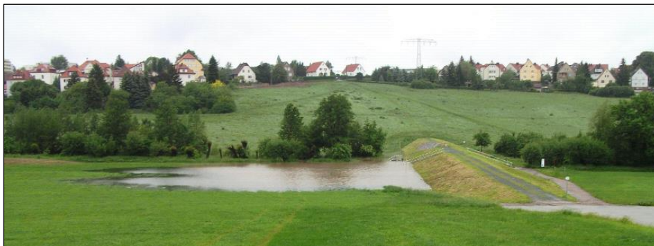
Bild 1.2 Teileinstau des HWRB Kaitzbach Mockritz (Kaitzbach 2) am 02.06.2013
