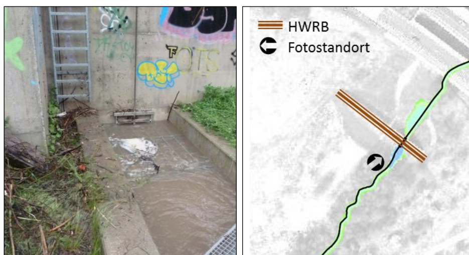
Bild 4.2 Vergleich der Wasserstände (li.: beobachtet; re.: simuliert) am HWRB Kaitzbach 3 (A 17) für das Ereignis 2013
