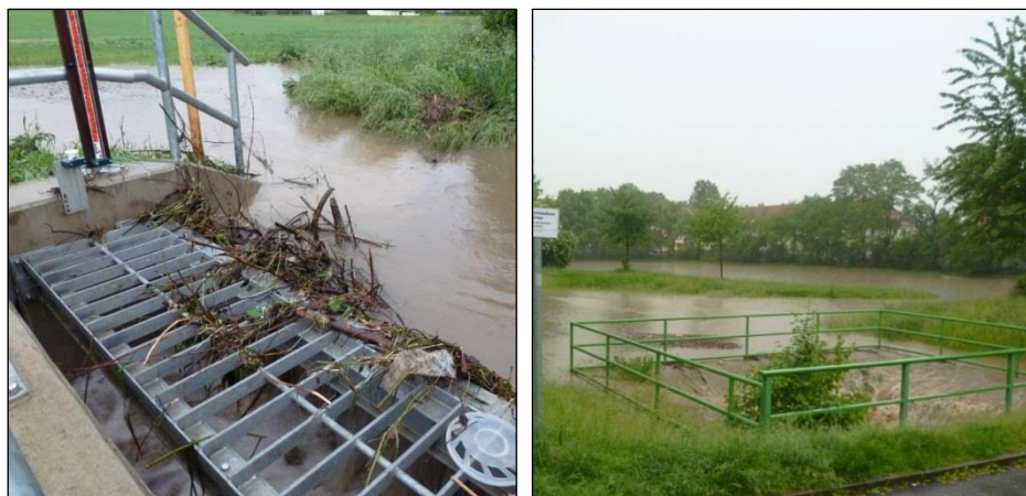
Bild 1.6 Links: Teileinstau am HWRB Kaitzbach Mockritz (Kaitzbach 2) am 27.05.2014; Rechts: Hochwassernotentlastung am 27.05.2014 19 Uhr am HWRB Kaitzbach Hugo-Bürkner-Park (Kaitzbach 1)
