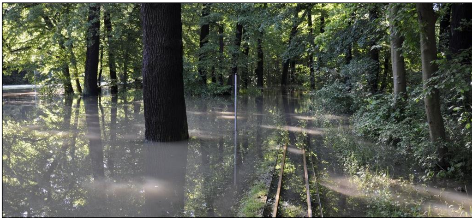
Bild 4.16 Überschwemmungen der Parkeisenbahnstrecke im Großen Garten am 05.06.2013
