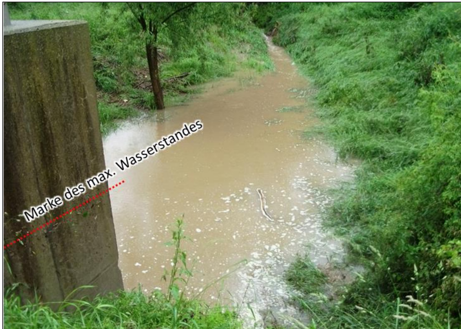
Bild 4.17 Wasserstand am HWRB Zschauke am 03.06.2013
