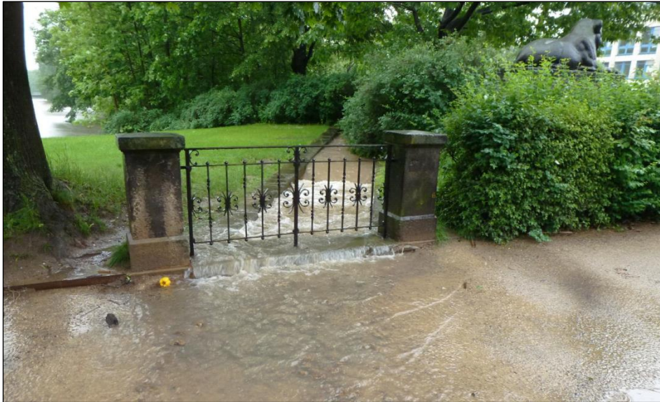
Bild 4.12 Überschwemmung der Brücke Querallee am 03.06.2013
