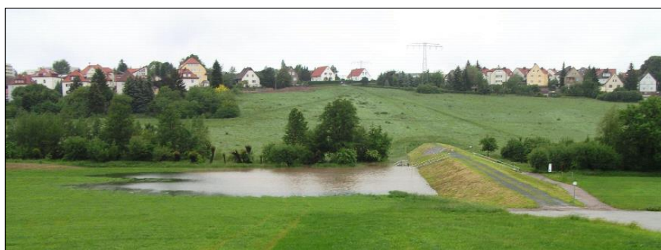
Bild 4.3 Wasserstand am HWRB Kaitzbach 2 (Mockritz) am 03.06.2013 (Fotostandort 1)
