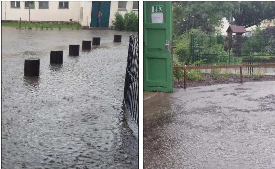
Bild 4.27 Wild abfließendes Wasser auf dem Schulhof der 47. Grundschule beim Ereignis am 27.05.2014
