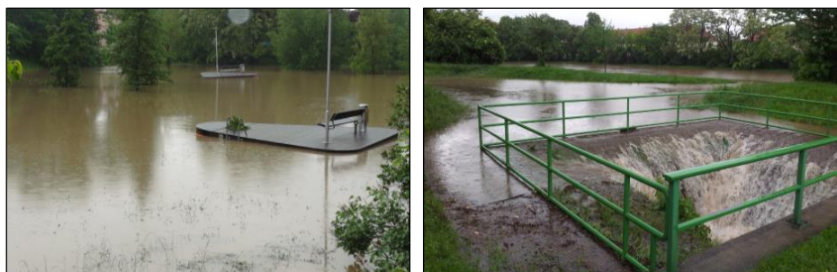
Bild 1.3 Links: Vollstau des HWRB Kaitzbach Hugo-Bürkner-Park; Rechts: Hochwassernotentlastung am 03.06.2013 10 Uhr am HWRB Kaitzbach Hugo-Bürkner-Park
