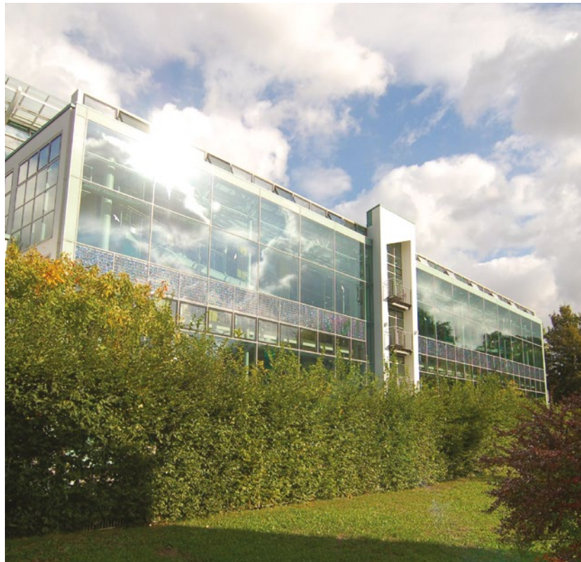
PV-Module in Streifen integriert in die Glasfassade eines Bürogebäudes
