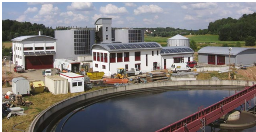
Indachanlage auf den gebogenen Dächern einer Kläranlage
