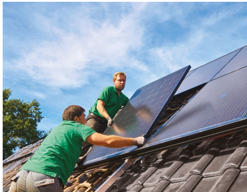
Aufdach-Montage von PV-Modulen auf einem Satteldach
