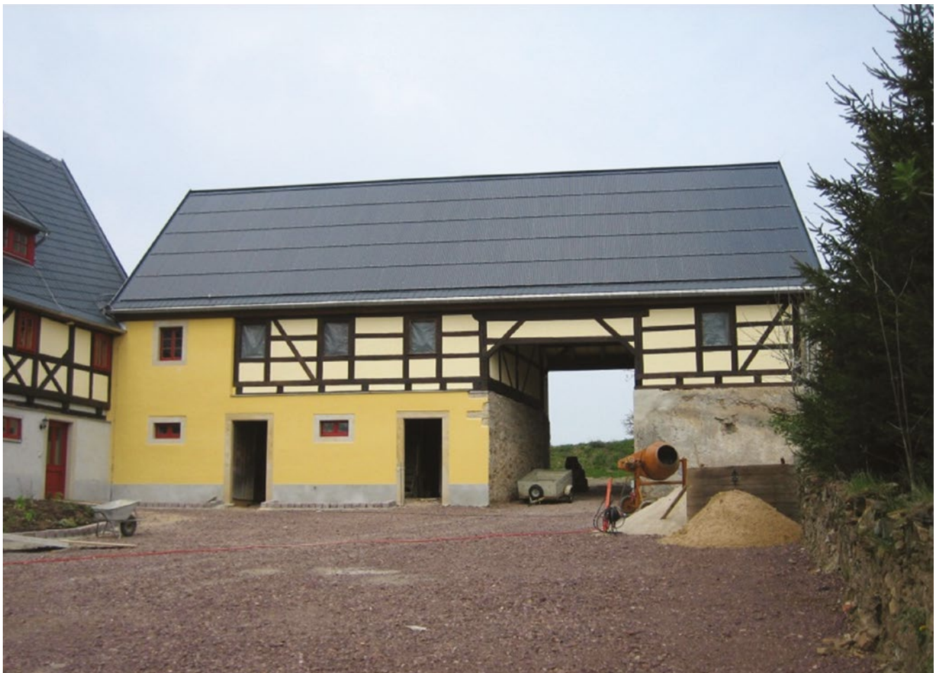
Seitengebäude eines Bauernhofes: die PV-Anlage wurde auf der gesamten Dachfläche installiert.
