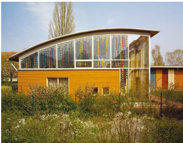
Südfassade eines Kindergartens mit künstlerisch gestalteter PV-Anlage
