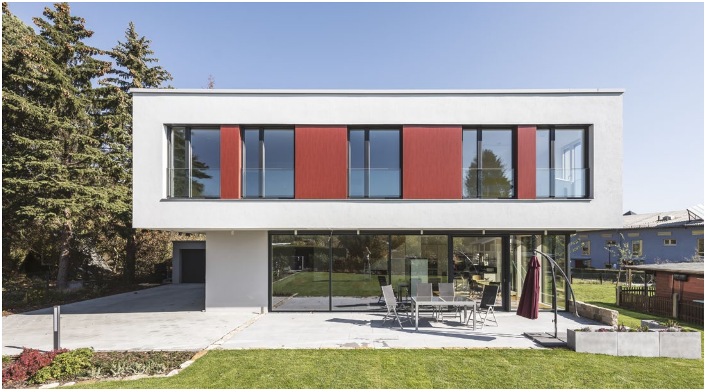
Gebäudefront mit Anlage in 15°-Südaufstellung
