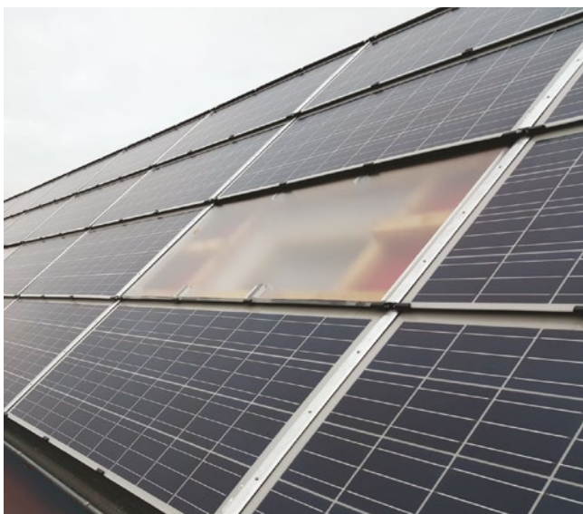
In PV-Anlage integriertes Plexiglas, dahinter befinden sich Dachfenster
