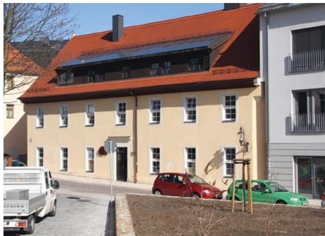
PV-Deckung der Gaube des denkmalgeschützten Hauses
