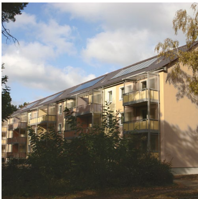
Thermische Solaranlage auf MFH
