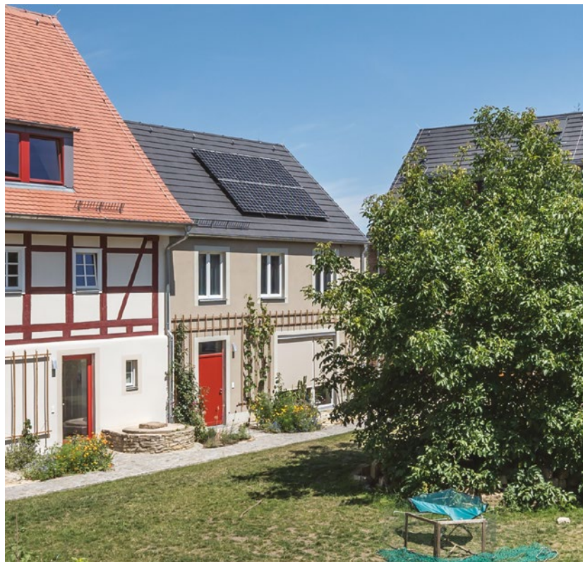
Aufdach-Anlage, schwarze Module auf schwarzem Dachziegel
