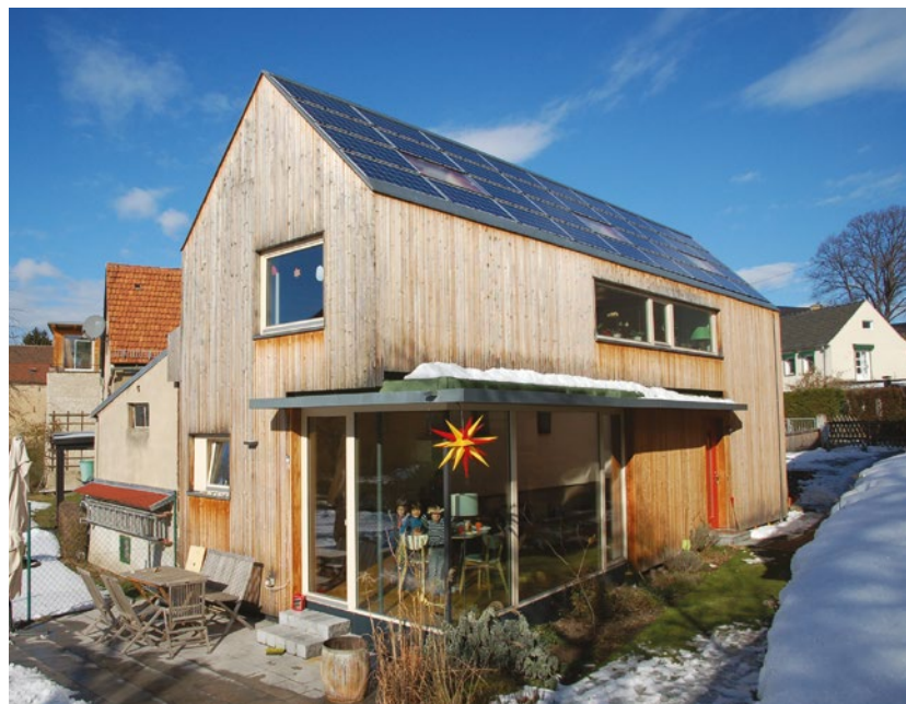
Indach-Anlage auf kompletter Süddachfläche eines EFH
