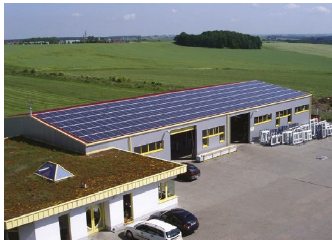
Aufdachanlage auf einer Gewerbehalle
