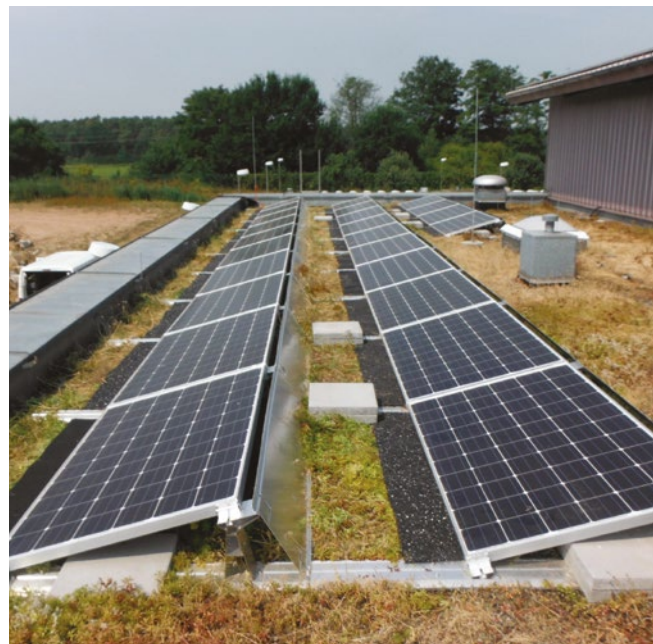
Beispiel Symbiose Photovoltaik und Dachbegrünung
