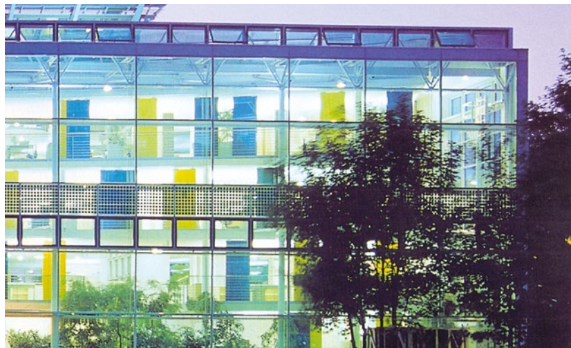
PV-Zellen auf Abstand in die 3-Scheiben-Isolierverglasung eingebaut, dadurch fällt Licht durch die PV-Glasfassade
