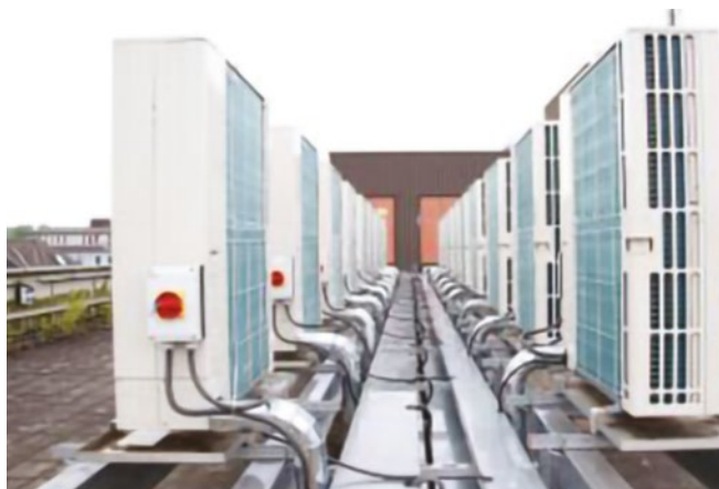
Dachaufstellung einer Wärmepumpenkaskade
