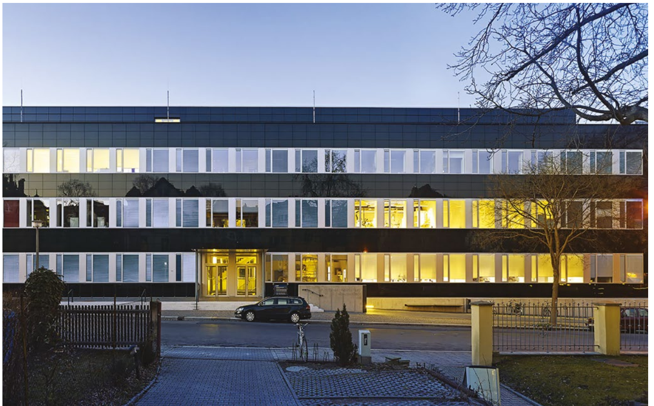
Laborgebäude: Südfassade und Dachgeschoss mit vorgehangenen PV-Modulen
