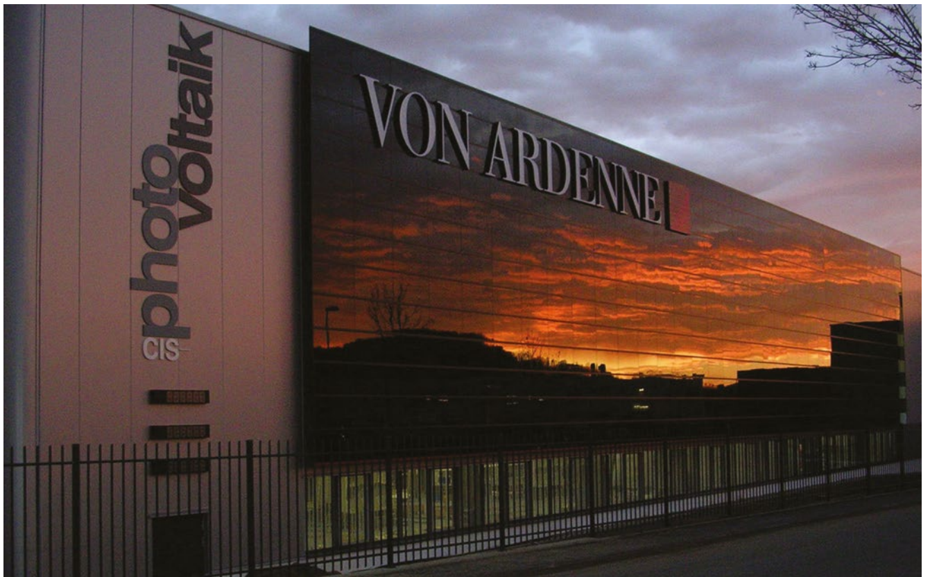
PV-Fassadenanlage an einem Gewerbebau
