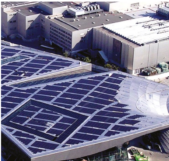
PV-Flachdach auf der BMW-Zentrale München
