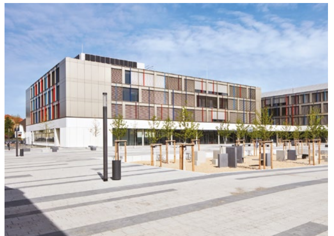
Schulgebäude. Die Technikzentrale auf dem Dach ist mit PV-Modulen verkleidet.
