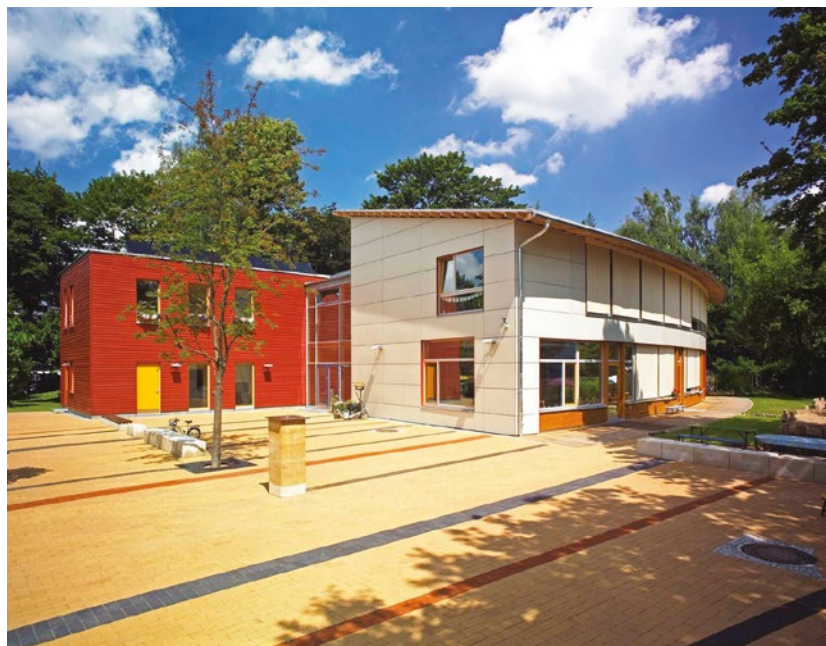
Flachdach-Anlage auf einem Kindergarten (roter Gebäudeteil)
