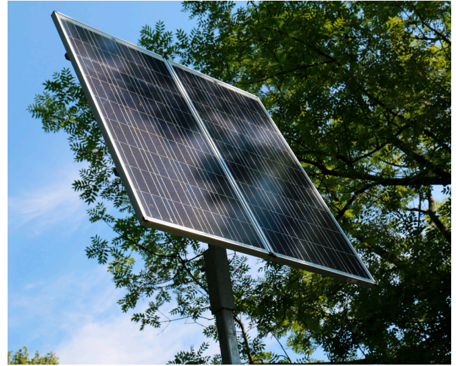
Stromversorgung der Toranlage über ein Solarpanel
