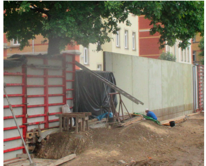
Sonderkonstruktion Wurzelbrücke zum Schutz der Eiche
