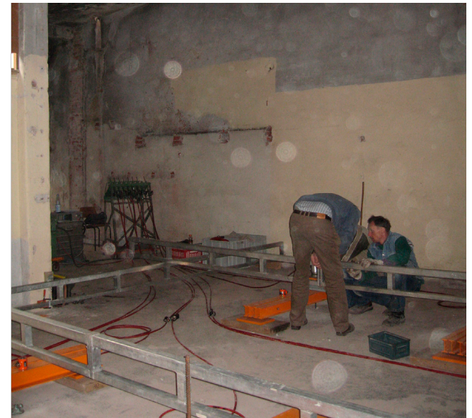
Konstruktion für Lasteintrag und Messtechnik im Obergeschoss
