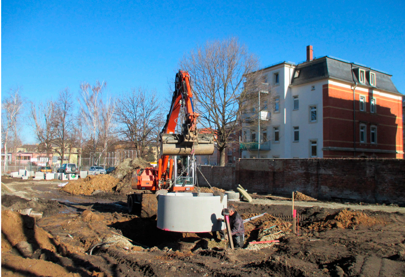
Einbau Aufsatz Brunnen für Wasserpumpe
