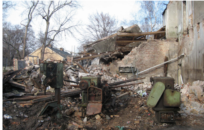
Abbruch der alten Maschinenfabrik
