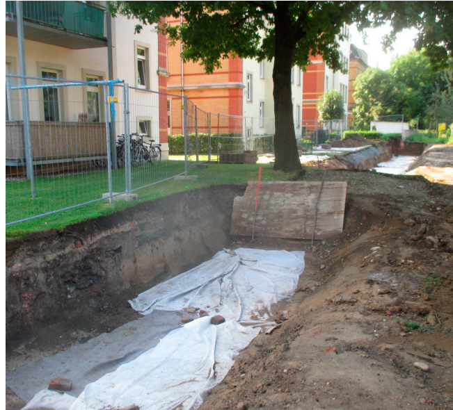
Fundamentgraben für neue Ortbetonmauer mit Aussparung des Wurzelraumes der Eiche
