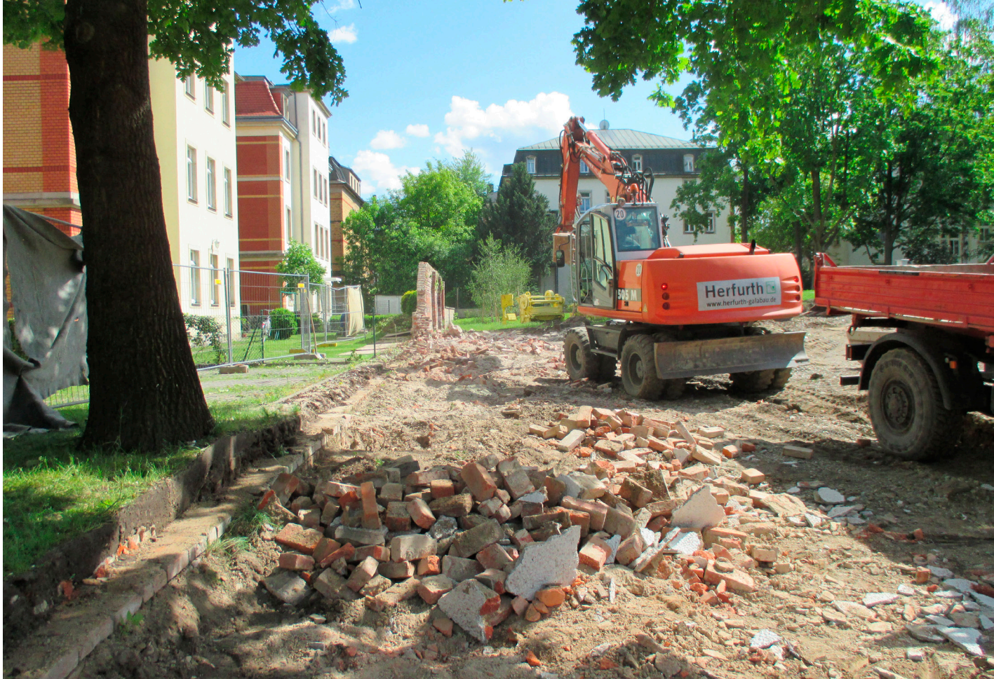
Abriss der alten Klinkermauer
