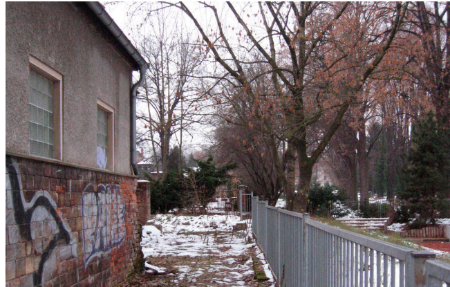
Badweg vor der Baumaßnahme
