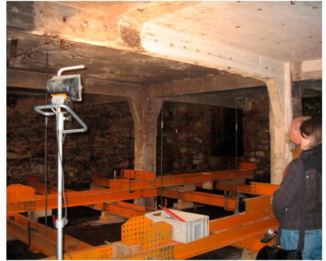
Wiederlagerkonstruktion für den Belastungsversuch im Kellergeschoss
