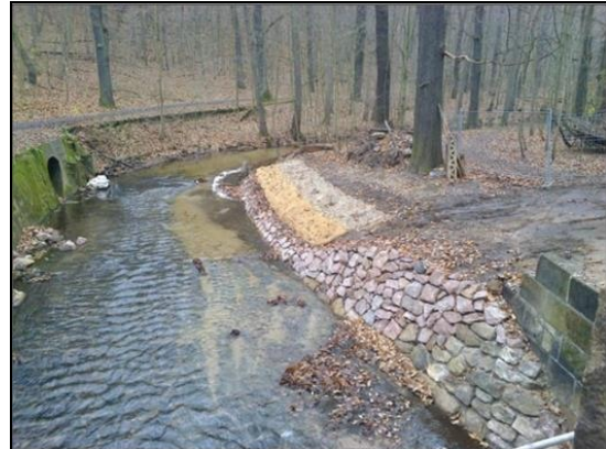
Abb. 8: Neue Ufersicherung statt Betonmauer, 09.10.2018
