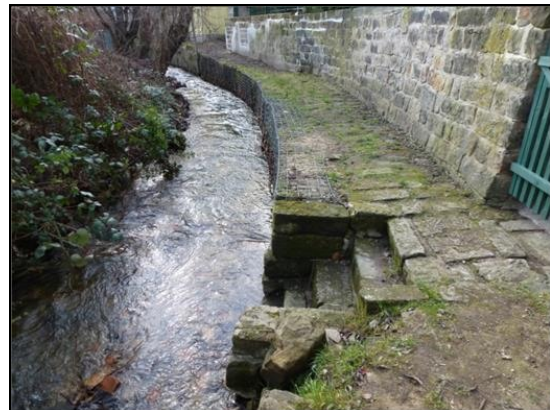
Abb. 10: Berme im Bereich Prallbogen nach Sanierung, 2015, 09.10.2018
