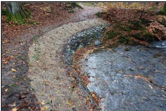
Abb. 9: Instandgesetzte Böschung im Bereich Wasserfall, 2016, 09.10.2018
