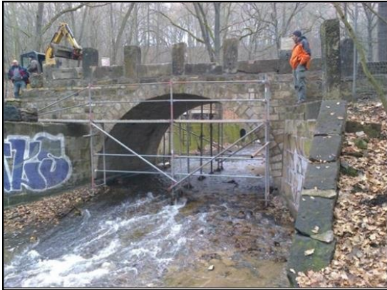
Abb. 7: Denkmalgerechte Sanierung der "Neuen Brücke" kurz vor Abschluss, 09.10.2018
