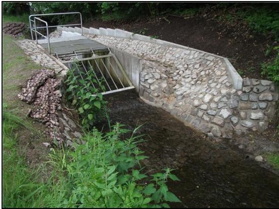
Abb. 9: Treibgut-/Geschiebefang mit seitlicher Überlaufstrecke, 02.06.2016
