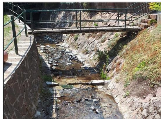
Abb. 6: nach der Maßnahme: Beseitigter Absturz und Befestigung mit Sohlriegeln, 23.07.2018
