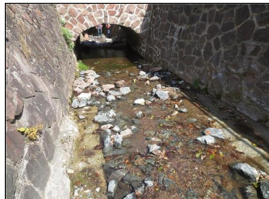
Abb. 5: nach der Maßnahme: Mit gewässertypischem Grobmaterial befestigte und strukturierte Gewässersohle im Bereich der Brücke, 19.07.2018
