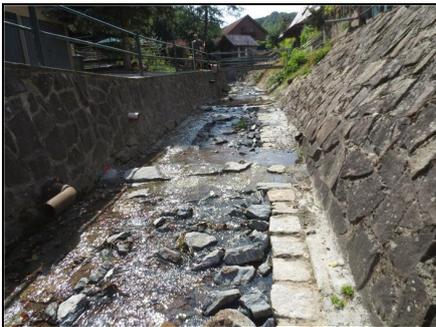
Abb. 4: nach der Maßnahme: Mit gewässertypischem Sohlmaterial befestigte, strukturierte Gewässersohle mit Unterfangung der Ufersicherung, 19.07.2018
