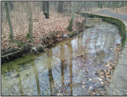
Abb. 3: Nach der Maßnahme: partiell rückgebaute Ufermauern, Bühnen zur Strömunglenkung und Initiierung von Sohlstrukturen, 09.12.2020
