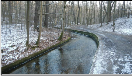
Abb. 2: Vor der Maßnahme: Uferverbau linksseitig mit Sandsteinquadern, 06.02.2018
