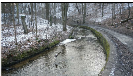
Abb. 1: Ufer rechtsseitig mit Ufermauer und "Prießnitzgrundweg", 06.02.2018
