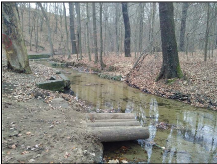
Abb. 4: Nach der Maßnahme: Fischunterstand, 09.12.2020
