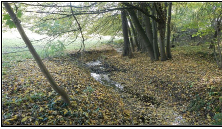
Abb. 2: Vor der Maßnahme: lückenhafter Gehölzgürtel, 17.10.2017
