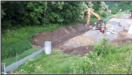
Abb. 3: Während Bau RRB B6, erster Teilabschnitt, an dem Pflasterung entnommen wurde, 15.05.2018
