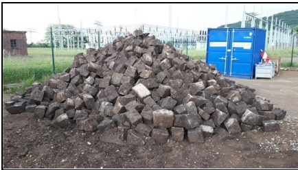
Abb. 4: Während Bau RRB B6, aus Gewässer entferntes Pflaster, 15.05.2018
