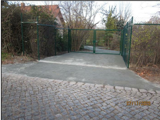
Abb. 2: Zugang von der Kölner Str. zu Flst. 4d mit neu errichtetem Tor, 27.11.2020
