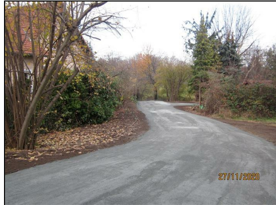
Abb. 3: Neu errichteter Zufahrtweg zum Roßthaler Bach für die Gewässerunterhaltung für die g. 27.11.2020
