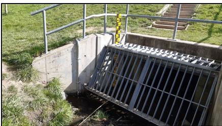
Abb. 1: Drucksonden des B<sub>Z</sub>W017 im HRB Kaitzbach 2, 16.04.2020
