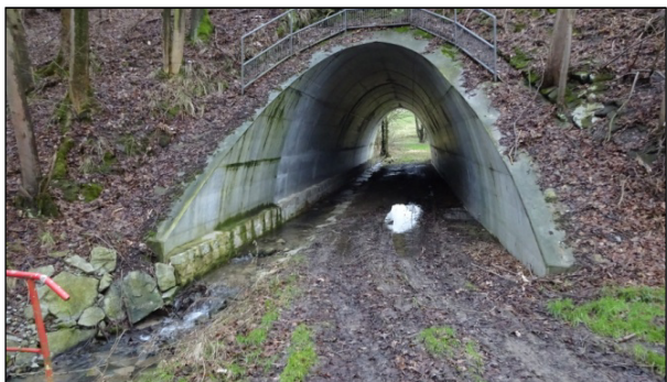
Bild 2: Eschdorf-Zaschendorfer Grenzbach, Durchlass Alter Bahndamm vor der Maßnahme
