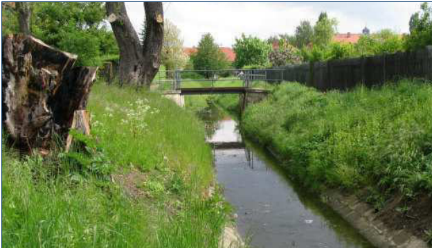
Bild 3: Steg am Grüngürtel und Uferverbau
