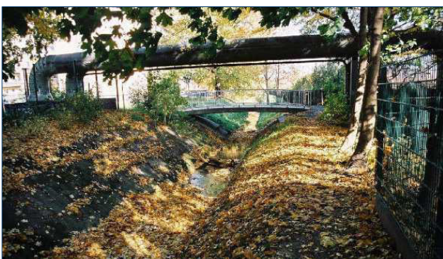
Bild 2: Blasewitz-Grunaer Landgraben im Bereich Rothermundpark
