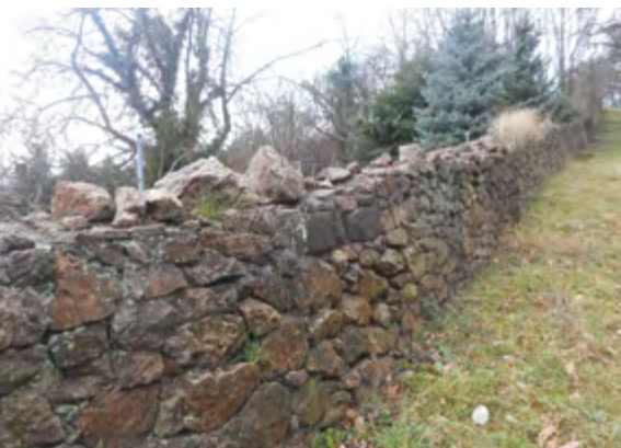
Abb. 124: Trockenmauer am Gnomenstieg Cossebaude
