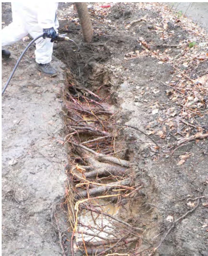
Abb. 144: Wurzelermittlung an einem Großbaum mit dem Saug-Spül-Verfahren. Im Unterschied zu anderen Verfahren werden damit sehr schonende und aussagekräftige Ergebnisse erzielt. © H. Seiche
