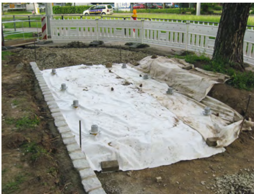
Abb. 145: Spezielle Wurzelbrücke über den Wurzeln einer Schwarzkiefer an der Zwinglistraße für das Anlegen des Radweges. Damit der Luftaustausch und eine hinreichende Wasserversorgung trotz des engfügigen Betonpflasters weiterhin möglich bleiben, sind zwischen dem Vlies und der Wurzelebene Drainagerohre aufgelegt worden, deren Enden beidseitig über offene Aluminiumkappen bis an die Oberfläche der Befestigung reichen. © H. Seiche
