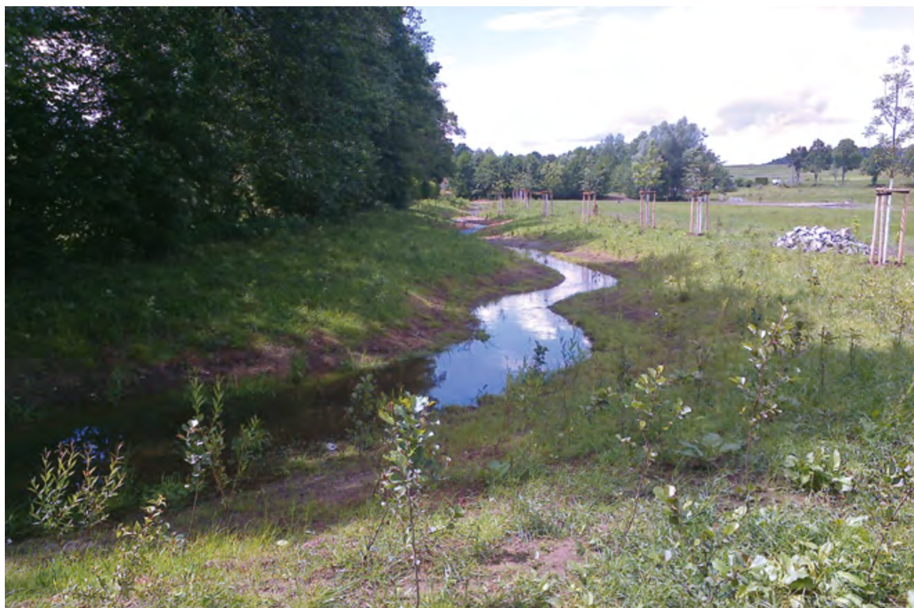
Abb. 167: Renaturierter Schullwitzbach kurz nach Fertigstellung 2016 © K. Otto
