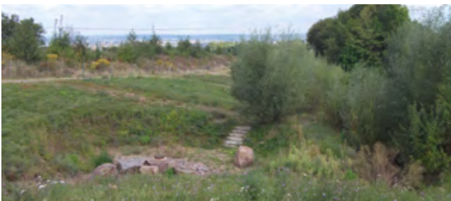
Abb. 170: Das Hochwasserrückhaltebecken Weidigtbach ist als Muldensystem angelegt. Die Mulden und Dämme sind ausgesprochene Magerstandorte mit entsprechender Vegetation. Der Gewässerlauf ist mit einem Ufersaum aus Weiden versehen. © K. Schumann
