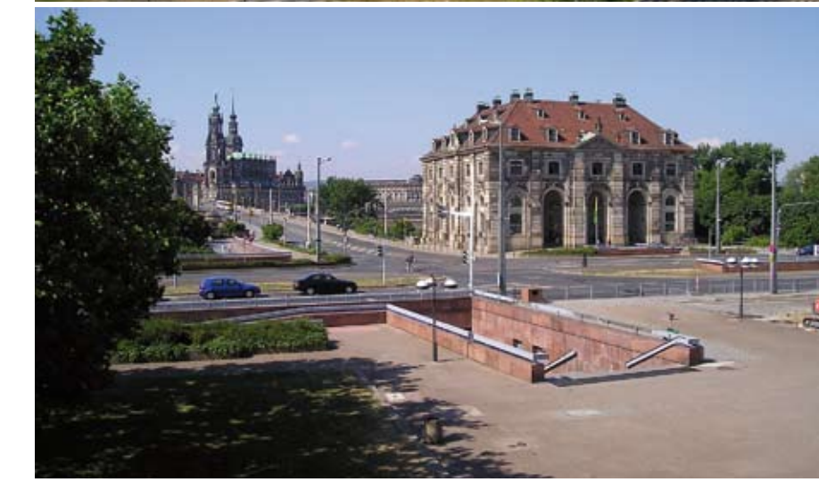
1 Die großen Radialstraßen wirken vielfach als funktionale und räumliche Barrieren - die Quermöglichkeiten für Fußgänger sind stark eingeschränkt (im Bild: die Albertstraße)
